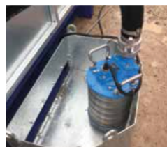
Sumidero montado en la superficie para un mantenimiento fácil
